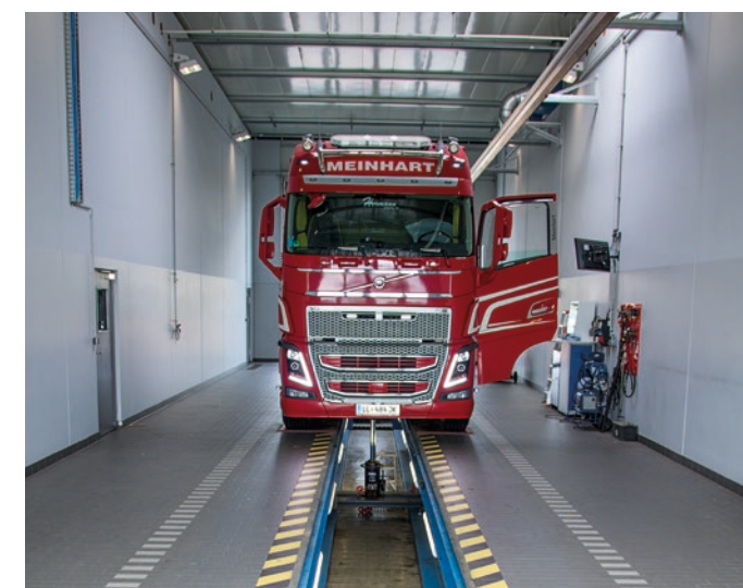
Das umfassende Service macht Petschl Werkstätten für Kunden zum One Stop Shop.
